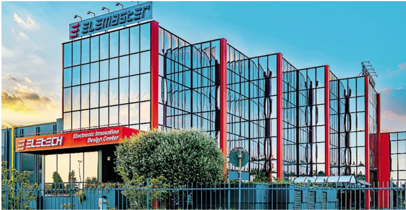
La sede di Osnago di Eletech Elemaster
