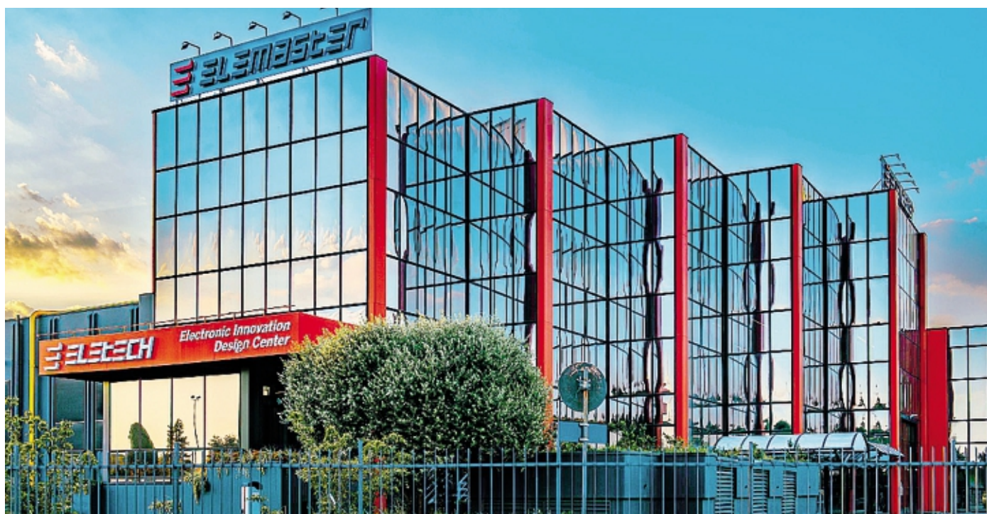
La sede di Osnago di Eletech Elemaster
