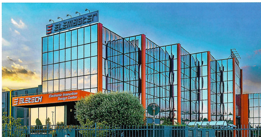
Lo stabilimento Eletech di Osnago
